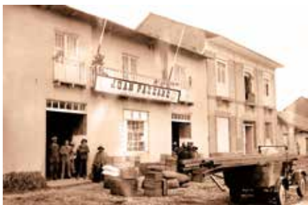
“La Tienda en su sede de Yunguyo al 50% de su construcción. Año 1925
